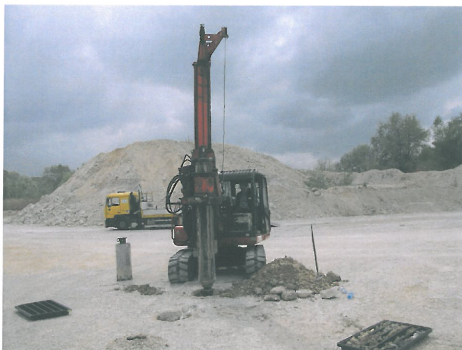
Foto 1 - Esecuzione sondaggio geognostico n°1.
